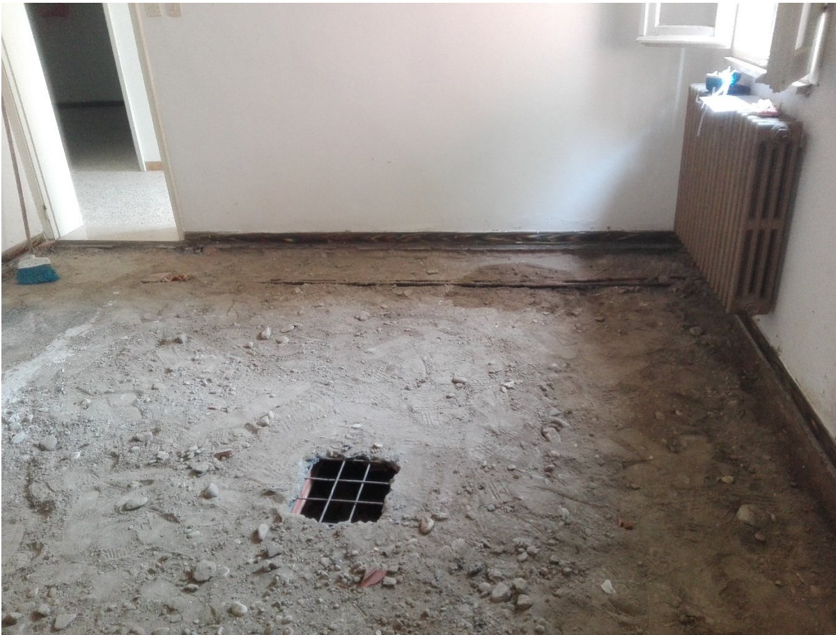
15) Particolare sondaggio solaio attuale "pranzo al piano terra"
