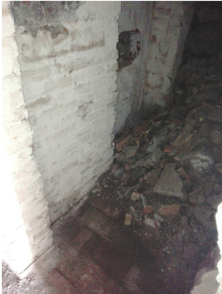
19) Sondaggio area "ripostiglio al piano seminterrato" con ritrovamento antica pavimentazione in mattoni e antiche aperture tamponate
