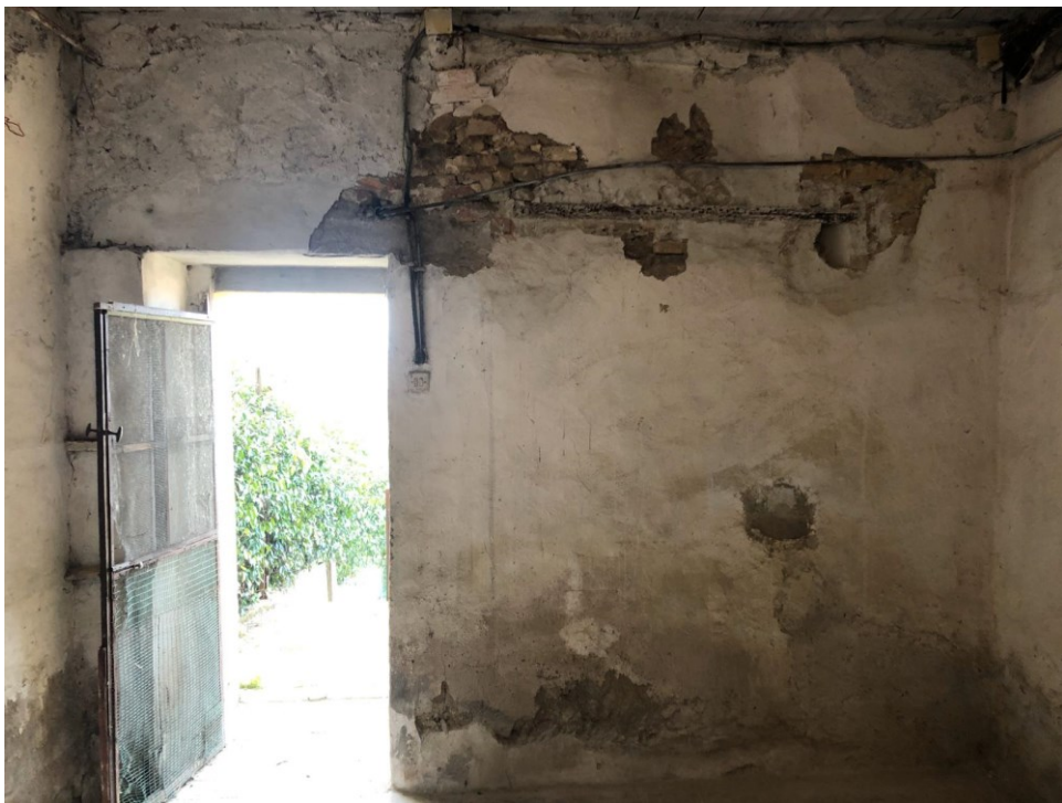
6) Foto apertura 3 (riferimento locale sgombero piano seminterrato)
