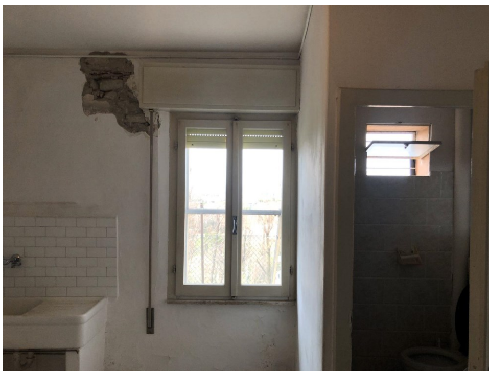
10) Foto interna apertura 4 e 5 (riferimento w.c. piano seminterrato)
