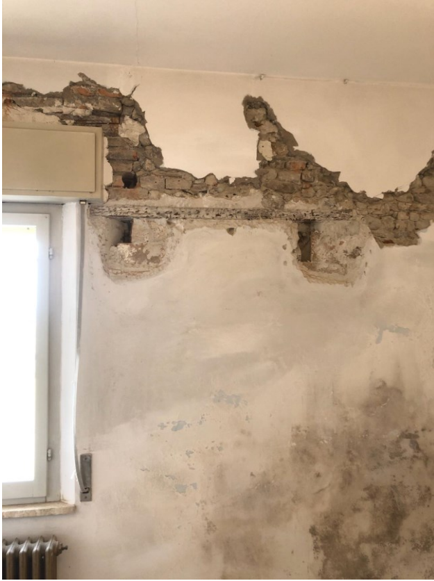
13) e 14) Particolare sondaggio con ritrovamento del vecchio architrave ligneo indicante un'antica apertura tamponata
