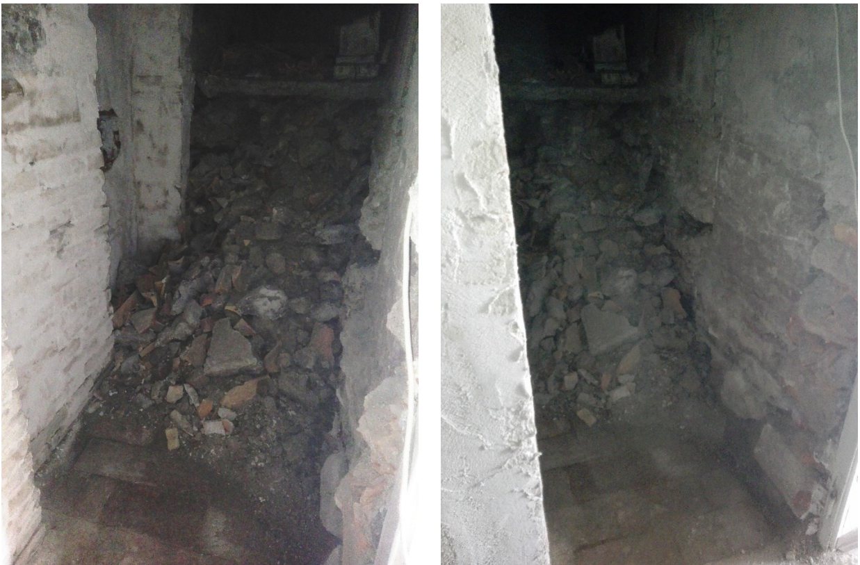
17) e 18) Sondaggio area "ripostiglio al piano seminterrato" con ritrovamento antica pavimentazione in mattoni e antiche aperture tamponate
