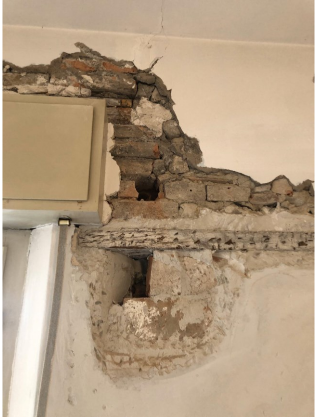
13) e 14) Particolare sondaggio con ritrovamento del vecchio architrave ligneo indicante un'antica apertura tamponata
