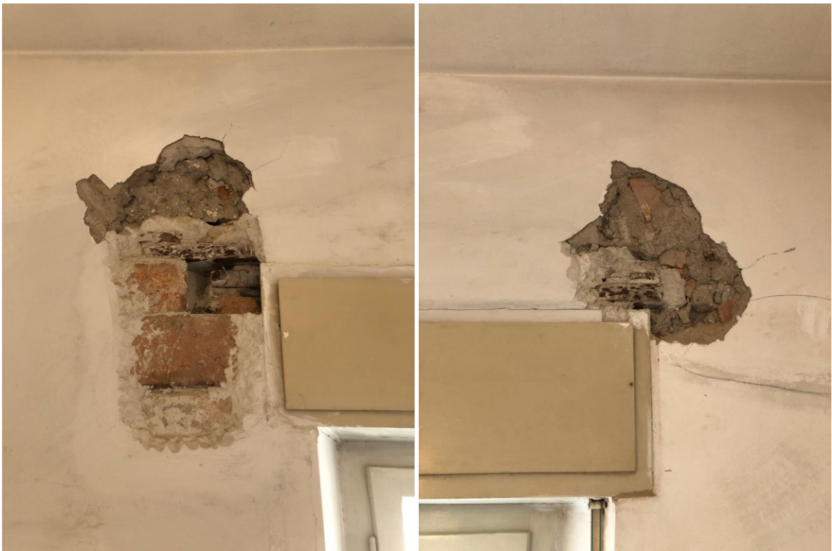
2) e 3) Particolare sondaggio vecchio architrave ligneo e delineamento sguinci dell'apertura originaria
